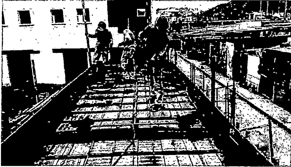
FOTO N° 05: Vaciado de concreto en losa aligerada.
