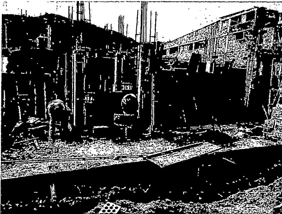
FOTO N° 02: Levantamiento de muros cuarto de bombeo.
